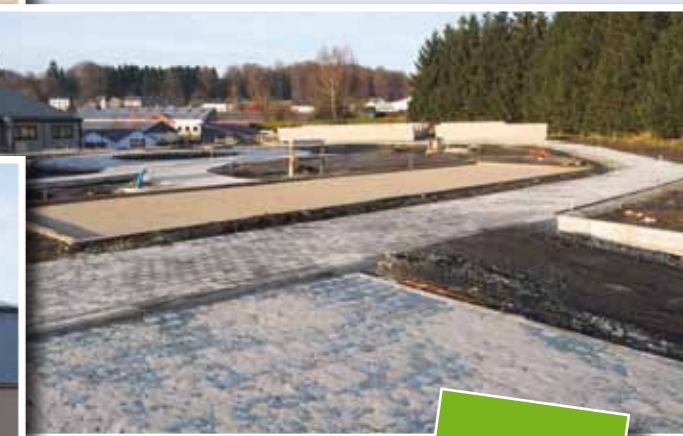
Aménagement extérieur - Libr'Accueil : zone de parc et de loisirs
